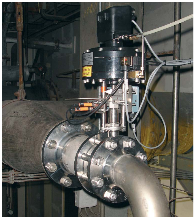
Umblaseventil an einem O 2 -Verdichter
