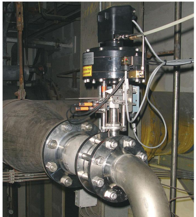
Umlaseventil an einem O 2 -Verdichter
